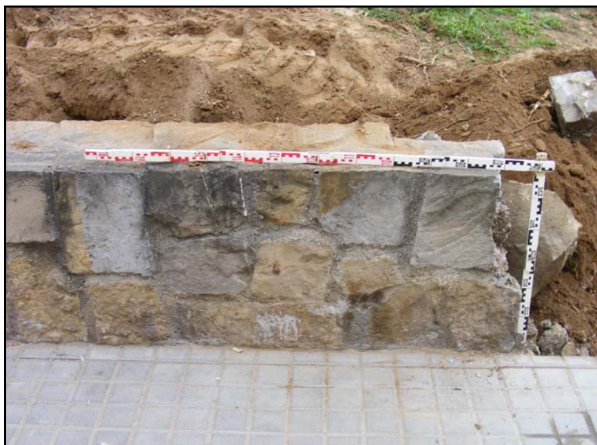
Figura 6.- Detall del mur U.E. 1001.
